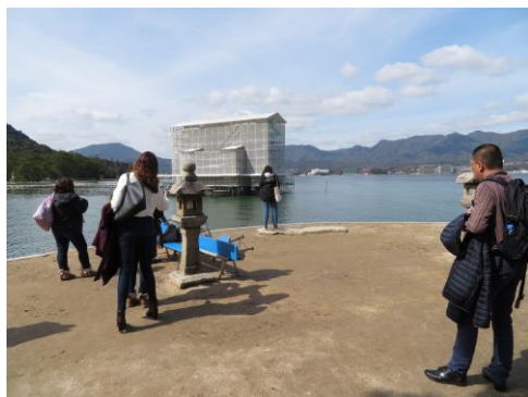
工事中の鳥居
