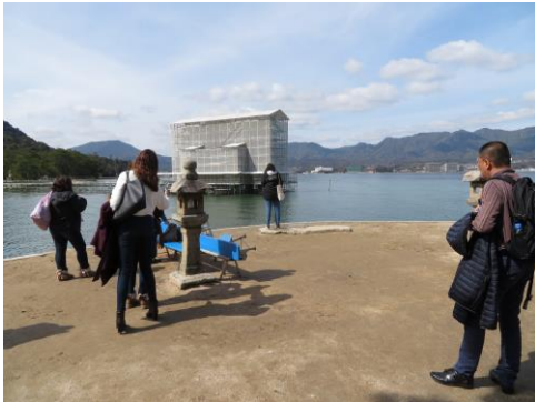
Le torii en travaux
